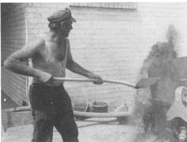
Abb.6. Schaufelbeschickung bei der Spritzbetonmaschine.
