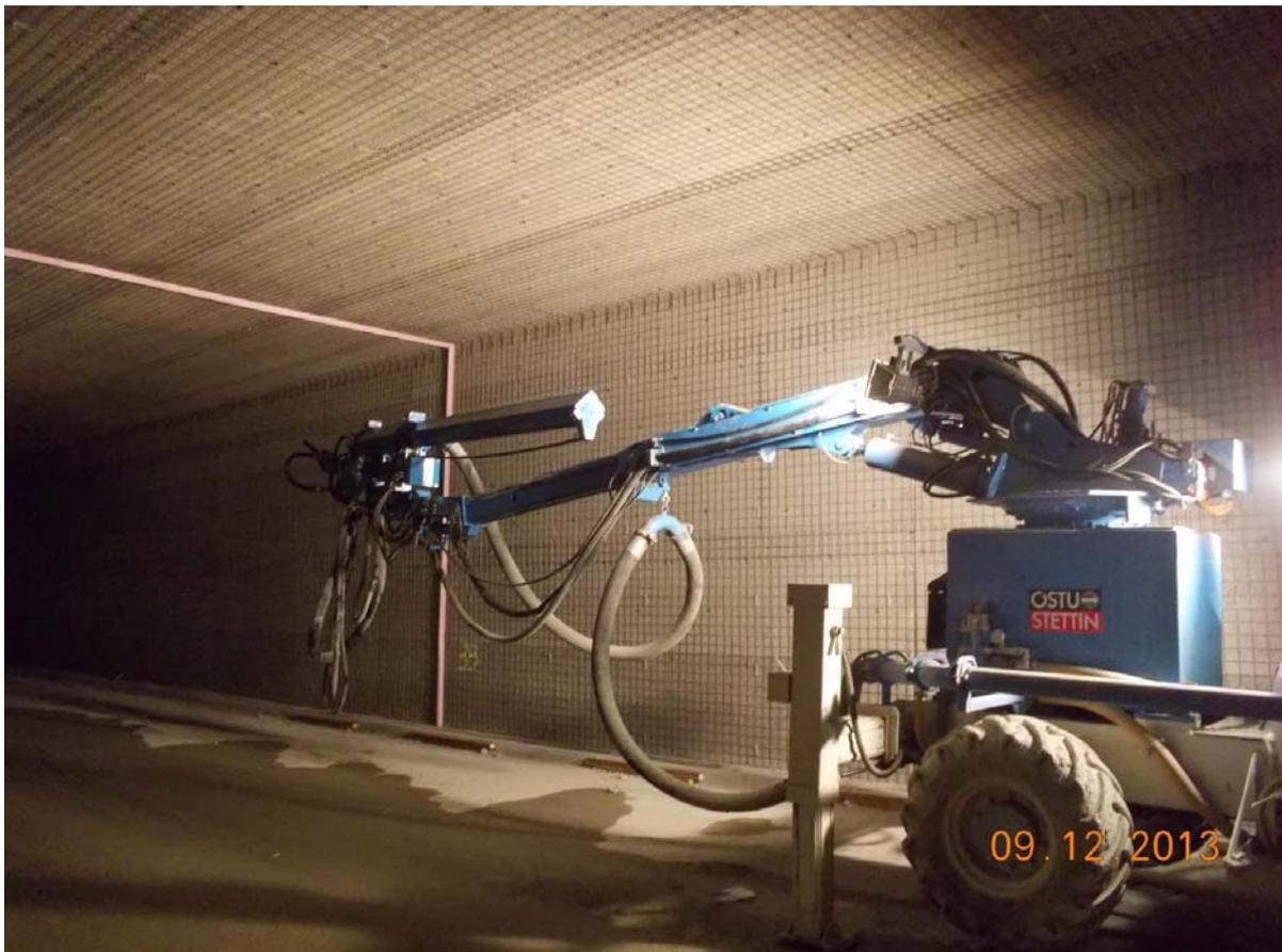
*Bild 5: Bewehren im UFT-Kastenquerschnitt*
