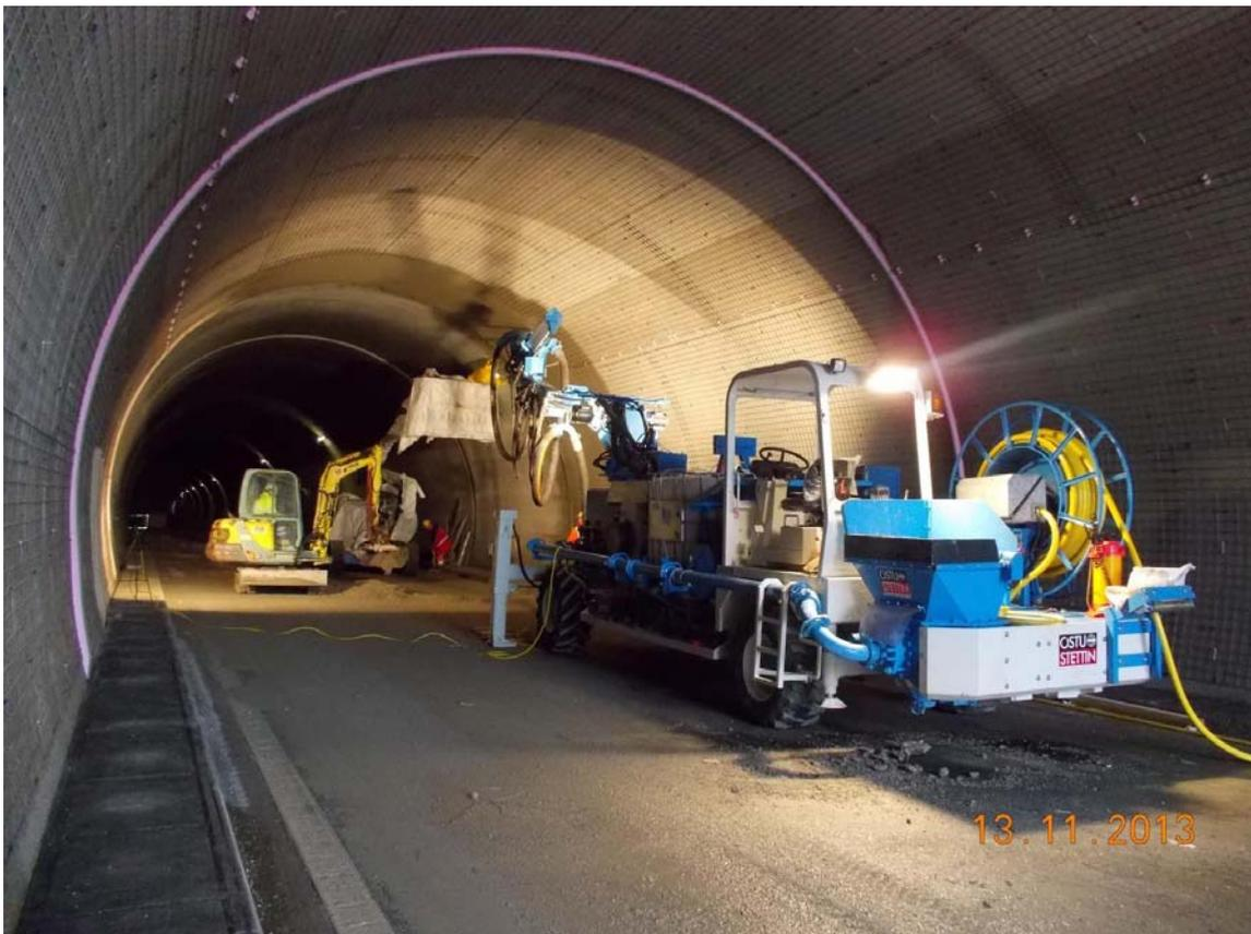
*Bild 6: Brandschutz-Spritzbeton mit Kunststofffasern - Tunnelquerschnitt*
