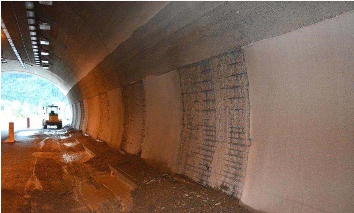
*Bild 4: Abtrag im Pilgerschritt-Verfahren*
