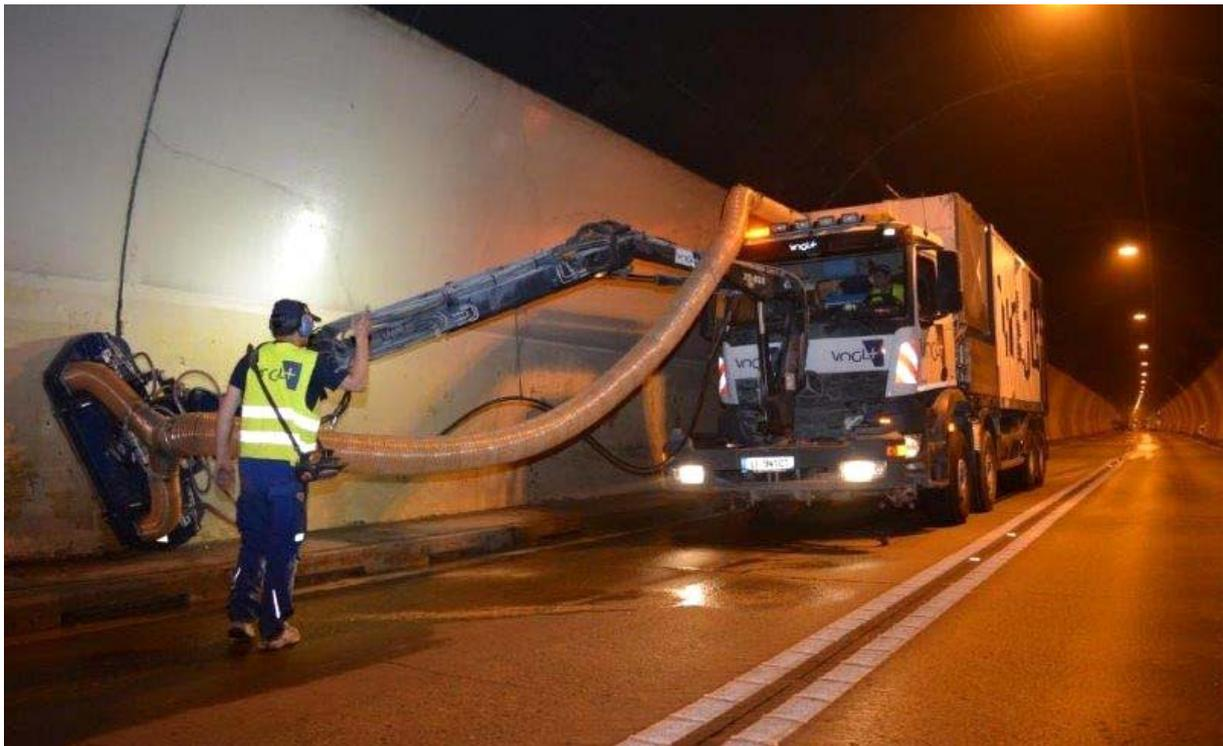
*Bild 3: Hochdruckwasserstrahlen im UG2-Bereich*
