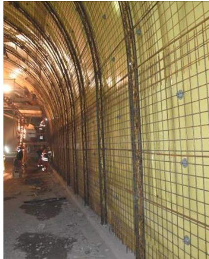
Bild 6: Tragbögen mit äußerer Bewehrungslage
