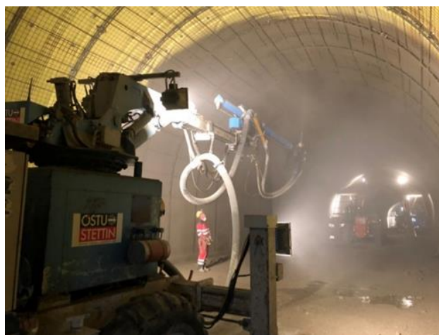
Bild 8: Auftrag erste Lage Spritzbeton (im Nassspritzverfahren)
