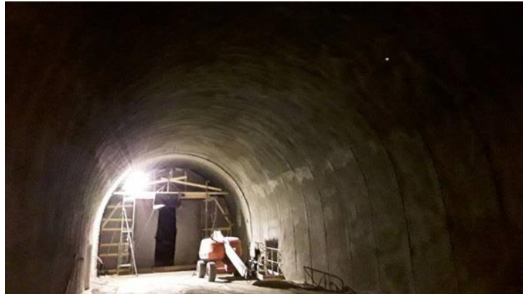
Bild 9: Spritzbetonoberfläche
