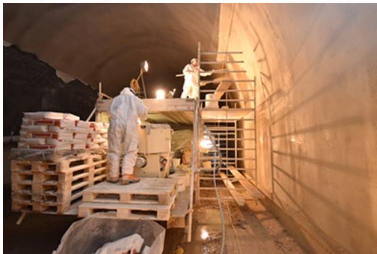
Bild 10: Spritzmörtel Auftrag
