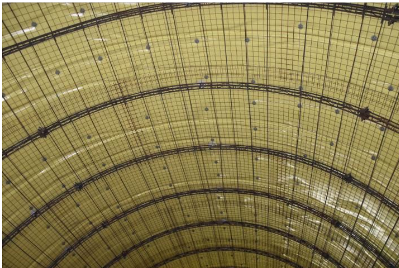
Bild 5: Tunnelabdichtung
