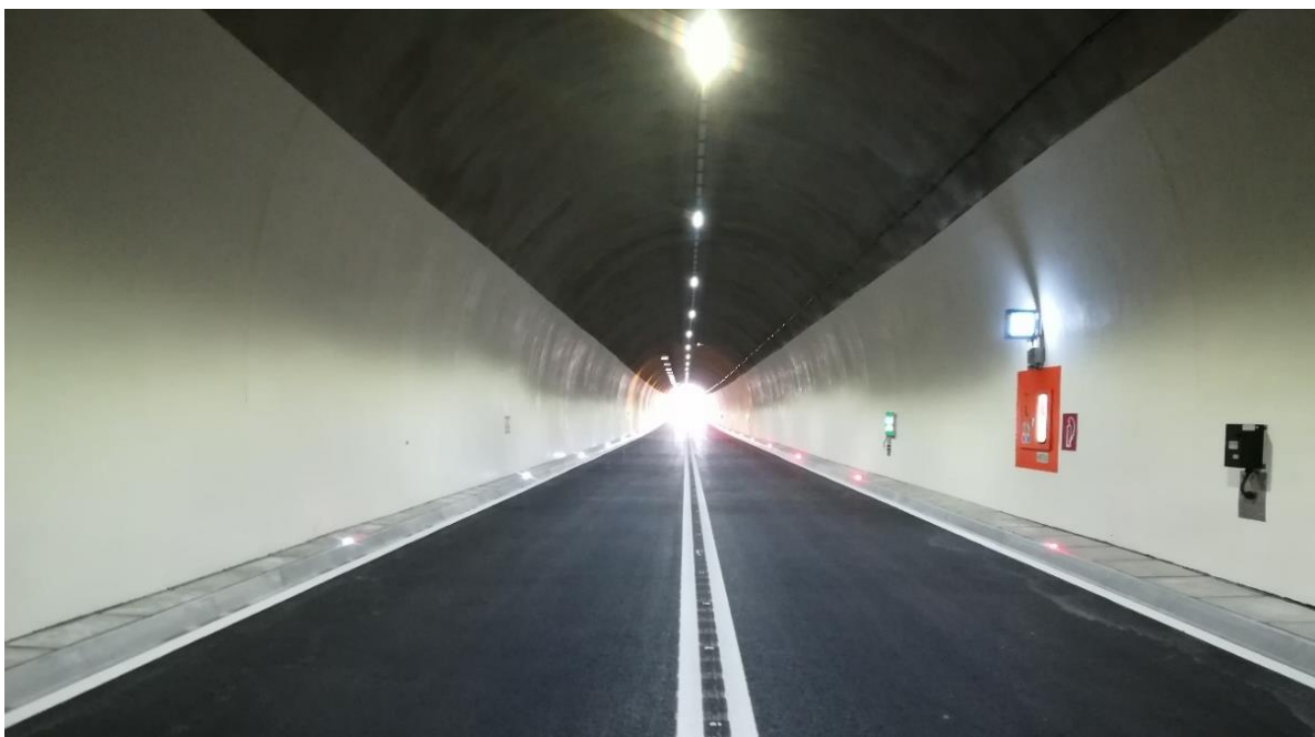
Bild 13: Tunnelröhre nach der Generalinstandsetzung
